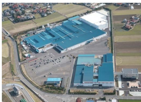
出雲工場（右上の白い建物が第6期棟）
