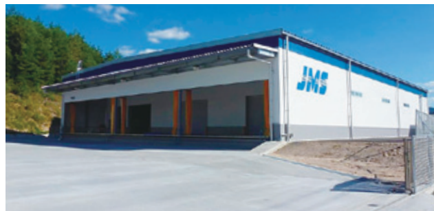
電子線滅菌棟外観
