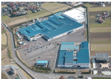
出雲工場（右上の白い建物が第6期棟）
